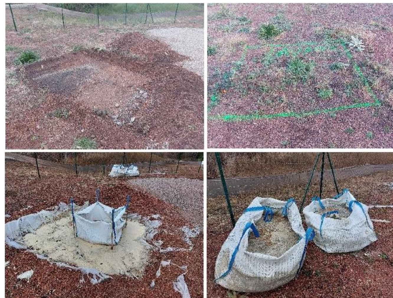
Exemple de zone créée pour le lavage des camions toupies avec mise en place d'un géotextile et stockage des laitances dans des big-bags avant évacuation (Chantier photovoltaïque d'Epinac - 71)
